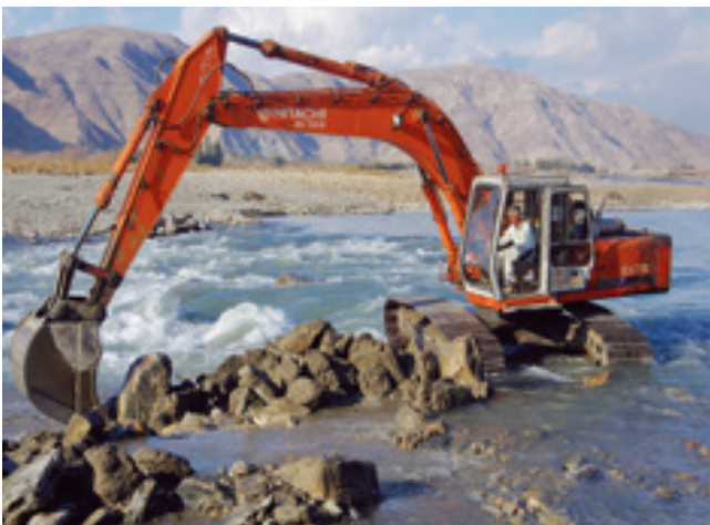
重機を使って取水堰(せき)工事に挑む中村医師
