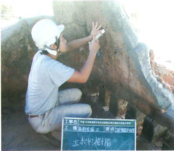
4. 亀裂充填状況 ひび割れ箇所にエポキシ樹脂を充填
