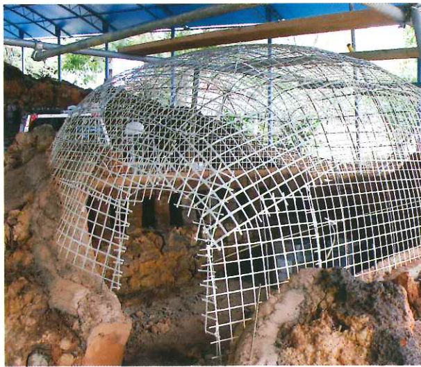
6. 上部補強状況 カーボン繊維組芯材
