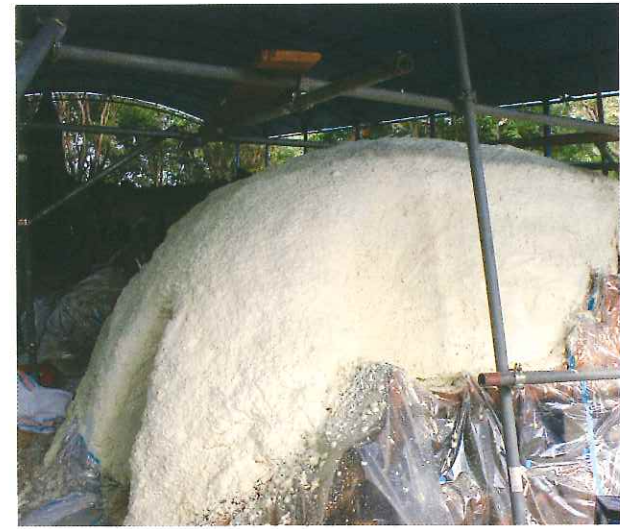
7. 上部補強状況 骨組みの上に発泡ウレタン吹付け後、 FRP (強化プラスチック) にて補強完了。
