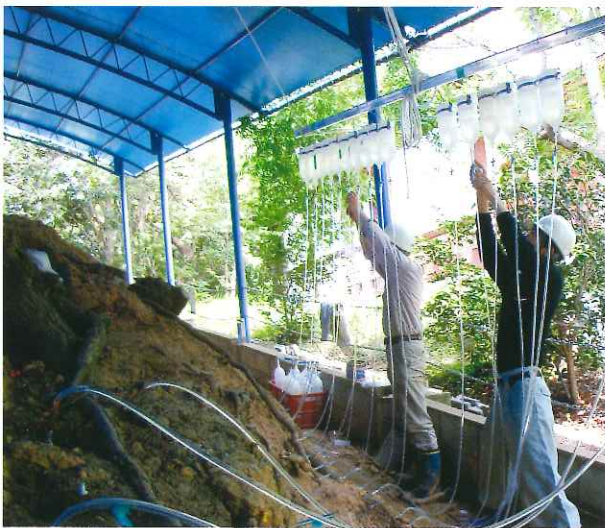
2. 基質強化処理状況 点滴方式で遺跡内部に樹脂を注入して強化
