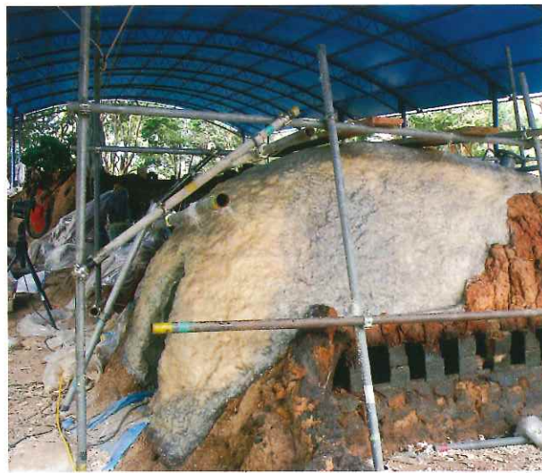
8. 上部補強状況 既存部分と違和感が出ないように 調色剤を仕上げ吹付け。
