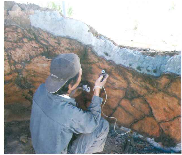
5. 擬土補修状況 表面が崩れた箇所を補修材で修理 (写真は既存箇所に合わせて調色している状況)
