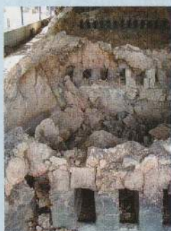
崩落した古窯跡
